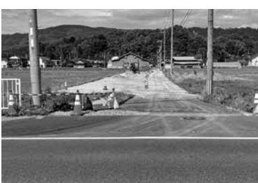
工事が進められている、「峰山インター線」
