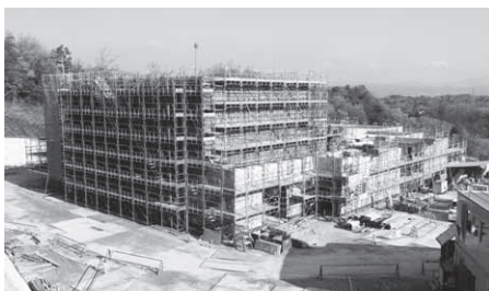
建設工事が進む新火葬場
