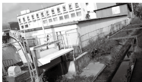
小栓川横の排水ポンプ付近に貯留施設を
