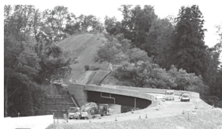
完成が近づく（仮称）森本IC付近
