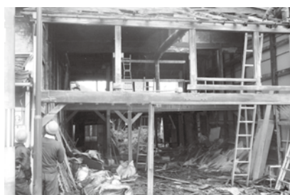
解体される家屋
