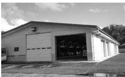
防災倉庫解体、再利用は無理か
