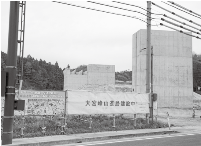
延伸工事の進む山陰近畿自動車道
