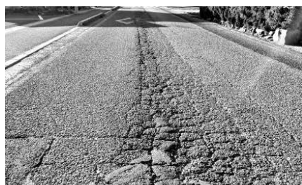
「幹線市道」のアスファルト舗装の状況
