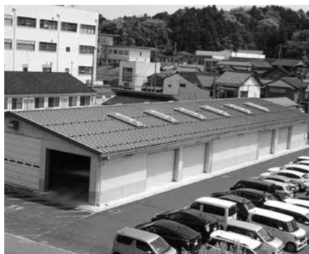
庁舎増築棟予定地
