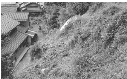
裏山の土砂災害
