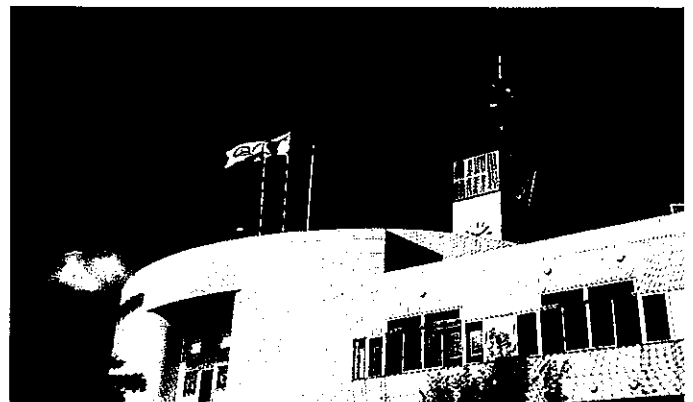
富士吉田市旗の掲揚(市役所峰山庁舎)
