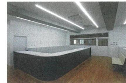
日射量の調整 ライトシェルフと縦ルーバーの組合せにより執務室内の日射量を調整すると共に、昼光センサー付きのLED照明によって適切な照度を確保
