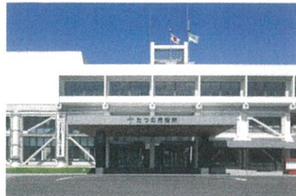
市民を迎え入れるエントランス大庇の増設 本館の正面玄関には新たに車寄せとなる大庇を増設し、雨に濡れずに市民乗り合いタクシー等に乗降できます。
