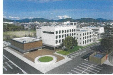
本館、新館及び多目的ホールを雁行 配置し、リズムカルに並ぶ庁舎外観
