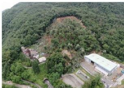
ながのし 地すべりによる被害（長野県長野市）
