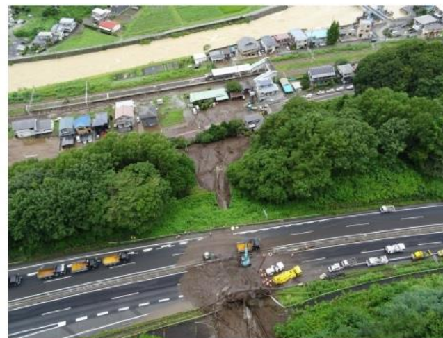
おかやし 土石流による被害（長野県岡谷市）
