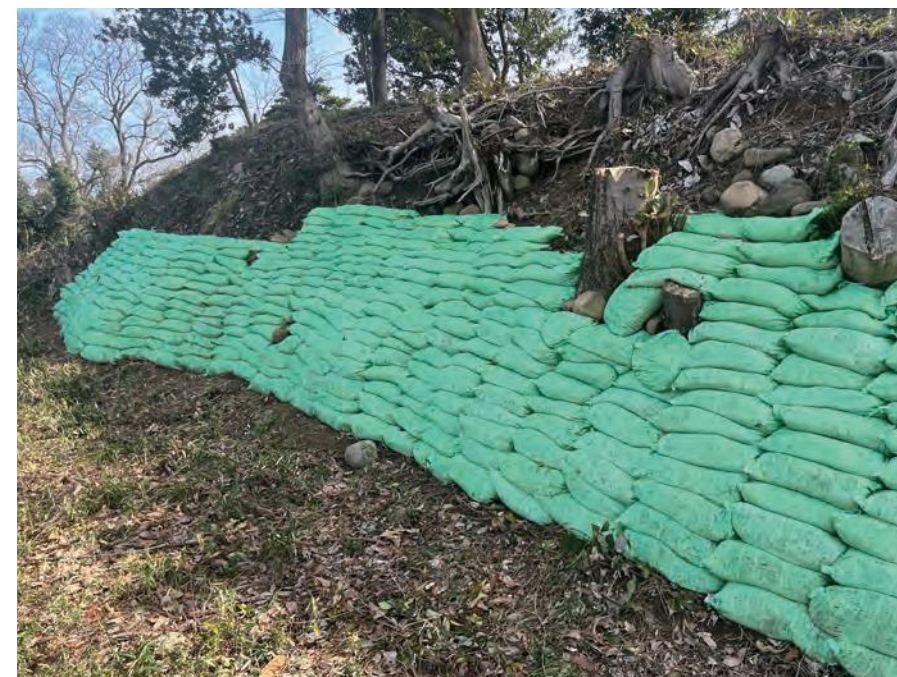
墳丘保存工 ― 土のう工2
