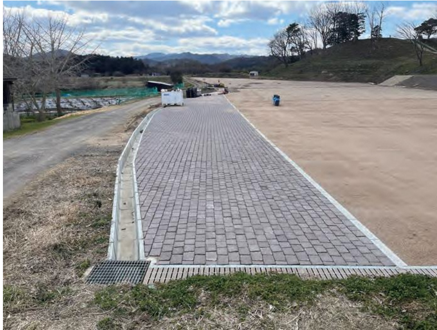
園路広場整備工 ― 擬石舗装
