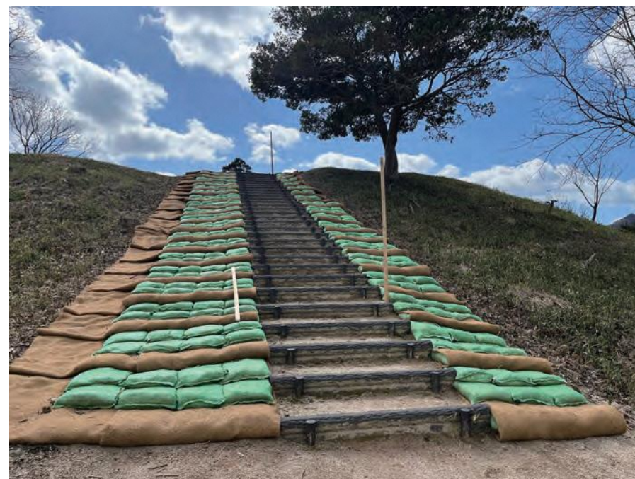
墳丘保存工 ― 土のう工1
