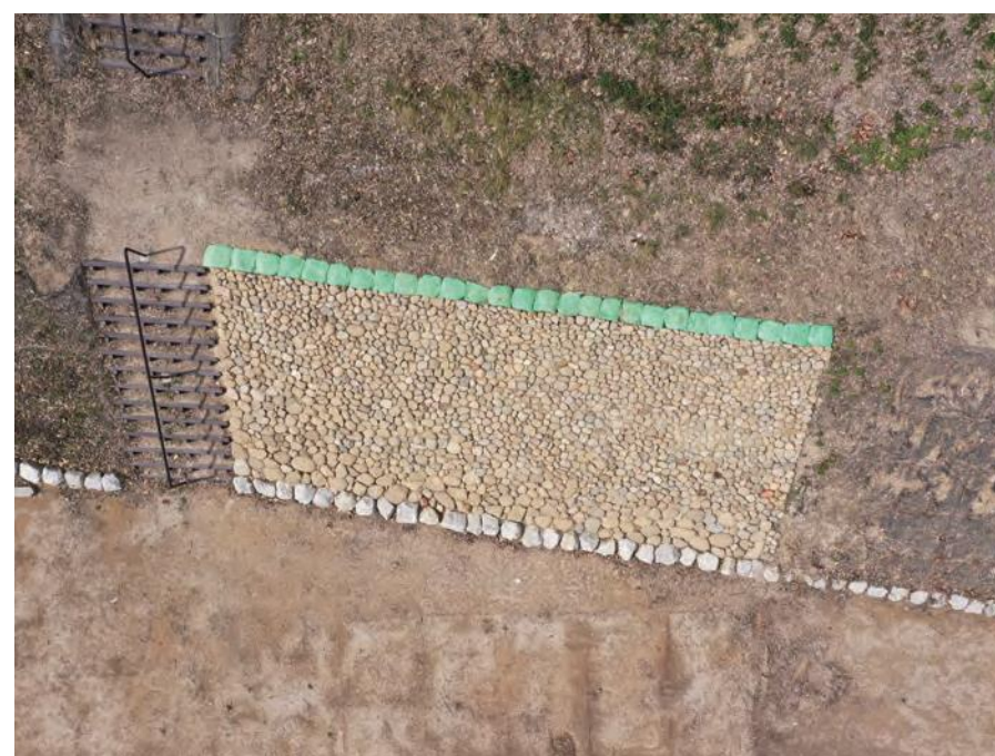
遺構復元工 ― 葺き石（ドローン画像）
