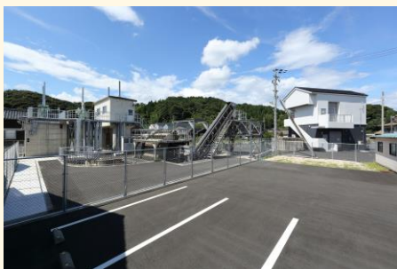
小栓川雨水ポンプ場
