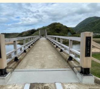
木製高欄補修完了 （てんきてんき橋）
