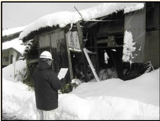
略式代執行により除却を行った住宅
