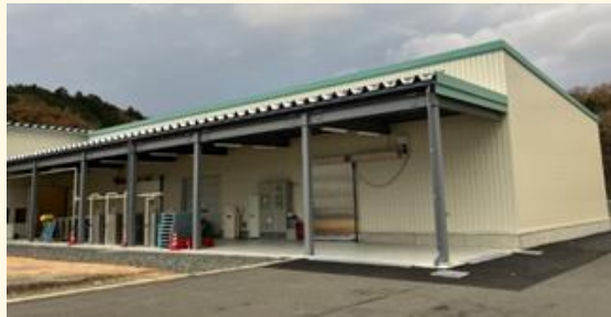
令和5年11月29日に竣工した工場
