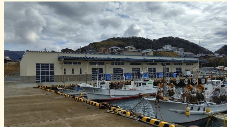
間人漁港衛生管理型荷捌き所
