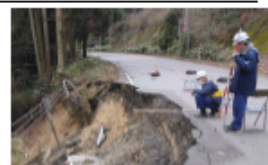
危険箇所での被災状況調査
