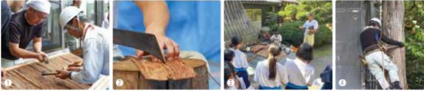
①職人が竹釘の打ち方を参加者に説明 ②2枚の檜皮を檜皮包丁の先端を使って縫い合わせる ③久美浜中学校生徒が檜皮の「拵え（こしらえ）」を見学 ④太いロープの両端に木の棒を括り付けた振り縄を使って木に登る
