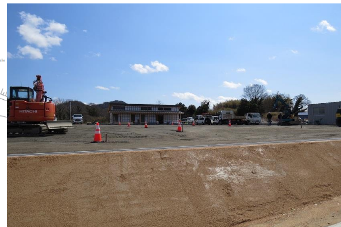
③ 駐車場工事の状況 3月中旬
