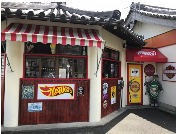
写真① 店舗外観
