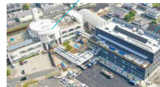
工事の様子 (R7.7.3撮影)
