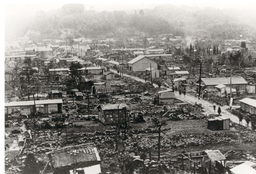
丹後震災による被害(峰山町)
