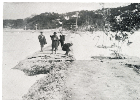
丹後震災による郷村断層(網野町小池地区)
