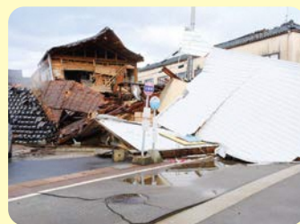
石川県穴水町の被害
