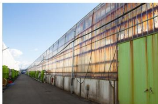
生ごみリサイクル施設の発酵棟。 約50日で堆肥になります。
