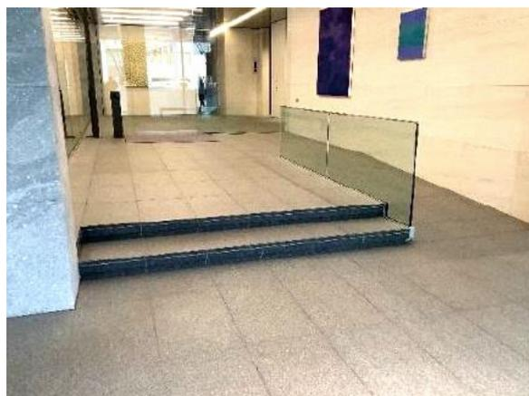
自然災害(洪水)への止水対策として1階地盤の高上げを検討
