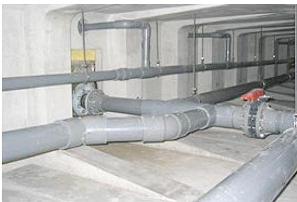
将来の設備更新に対応できるように、床下に設備専用のスペースを設置
