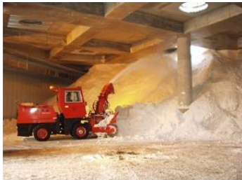
熱源として利用する雪を保管する「貯雪庫」 (出典:札幌市)
