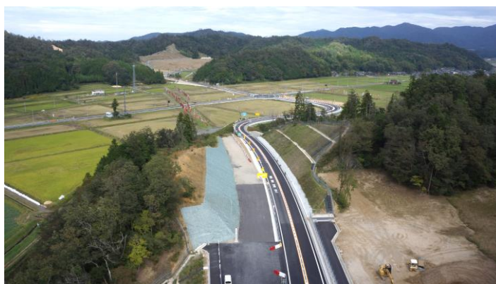
更なる延伸に向けて工事が進む山陰近畿自動車道 (京丹後大宮インターチェンジ付近)
