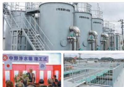
中野浄水場竣工式、ろ過施設と薬品沈殿池
