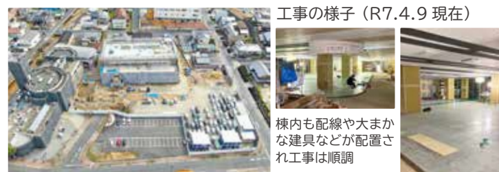
工事の様子（R7.4.9 現在）
