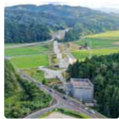
京丹後大宮ICから延伸中の山陰近畿自動車道
