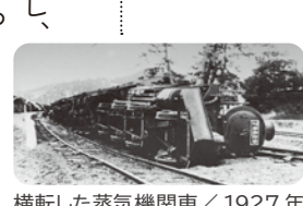
横転した蒸気機関車／1927年 3月7日に発生した北丹後地震 (M7.0)により被災
