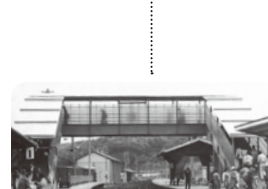
4月23日に架設した陸橋
