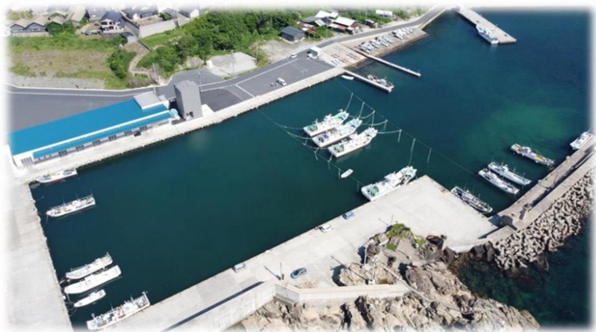
【間人漁港衛生管理型荷捌所・殺菌冷海水施設（令和元年度完成）】
