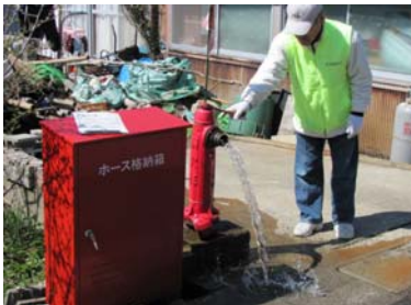
【3月実施の消火栓等点検】
