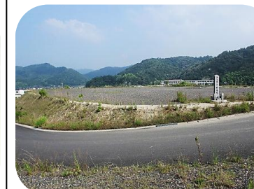
平成14年に完成した防災施設
