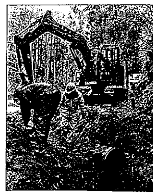
区内・市道の整備（排水管布設）
