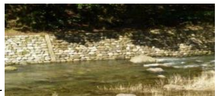
石積による護岸工事
