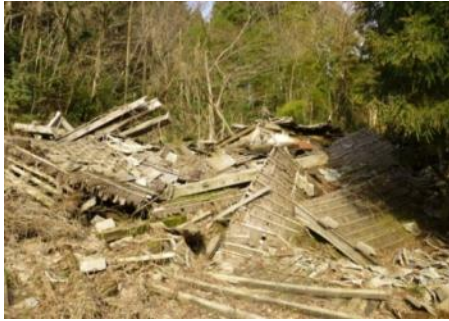
倒壊した家屋と家屋跡
