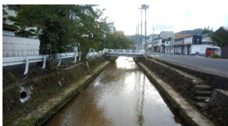
早苗橋から朝日橋を望む
