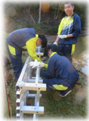
組立作業中です
