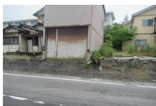
隆起により段差は約1m
