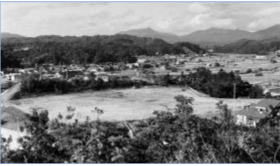
丹後文化会館建設前の扇谷グラウンド
