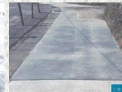
道路舗装工事 (上野地内)
