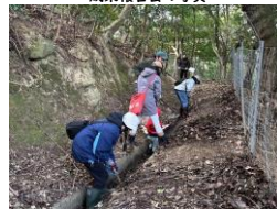
でんご山水路の清掃作業
