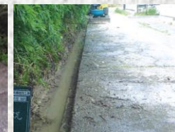
水路土砂撤去 (家ノ谷地内)
