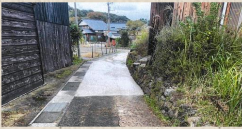
舗装修繕 （上野地内）
