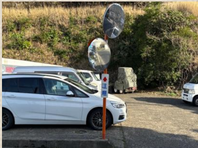
カーブミラー修繕 （間人地内）
