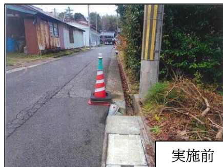
溝谷久原団地線道路側溝修繕工事
