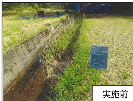
黒部川浚渫工事
