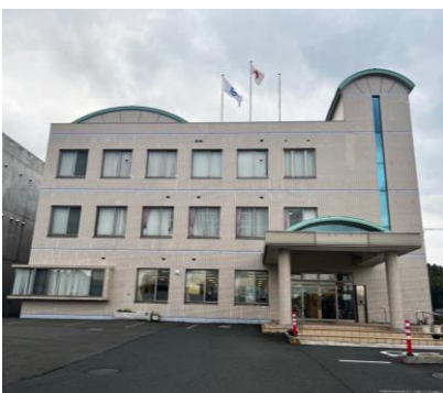
外壁の改修工事を行いました
