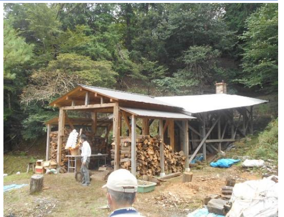
▲再建された建屋と穴窯
