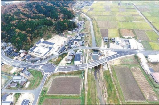
整備後(上空から) 下側が新しい道路(延長500m)です。
