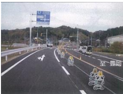
整備後 道幅も広くなり見通しがいいのがわかります。
