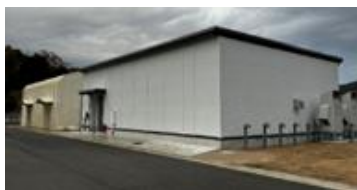
R5に竣工した干芋加工工場
