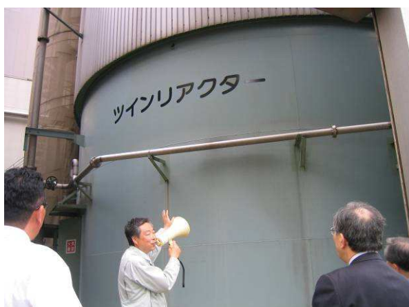
高温、高速メタン発酵を行なうツインリアクター
