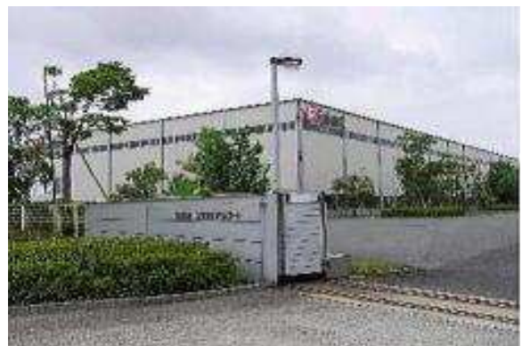
工場施設全景
