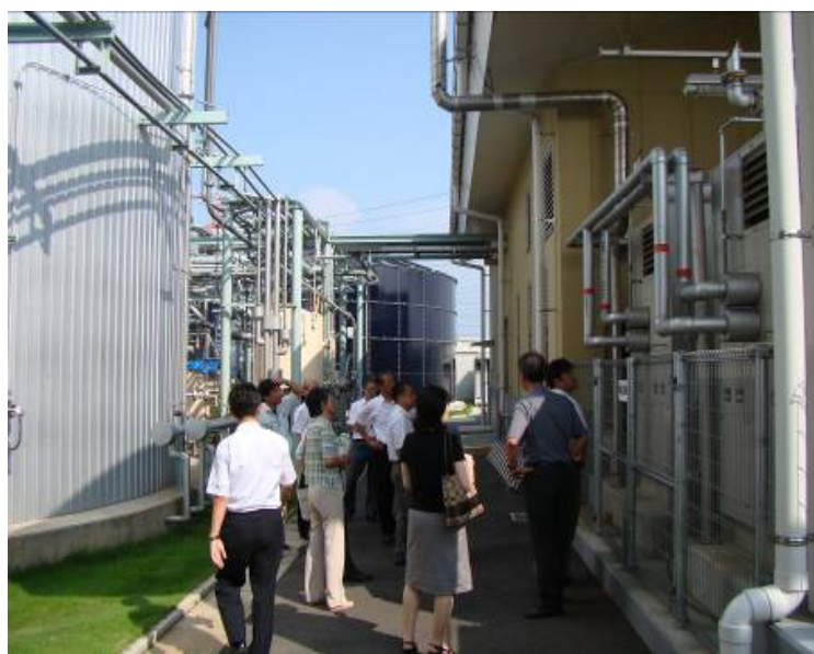
大木環境センターくるるんの脱臭施設
