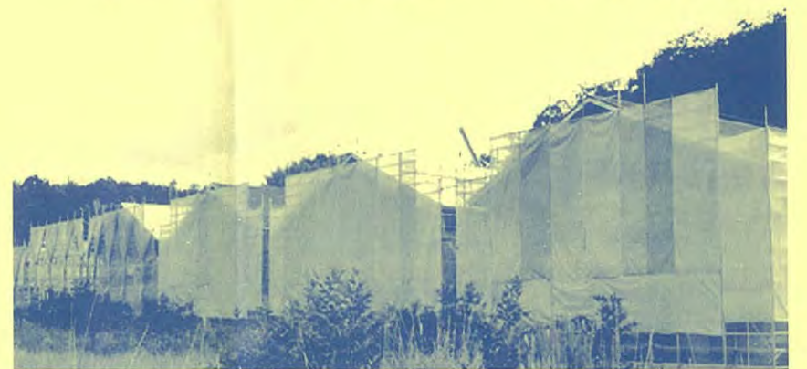
急ピッチで建設が進む米軍属の集合住宅/網野町島津
