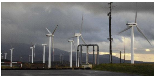
最初に設置された仁賀保高原風力発電所
