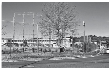
峰山市街地にも近い、旧丹波小学校跡施設
