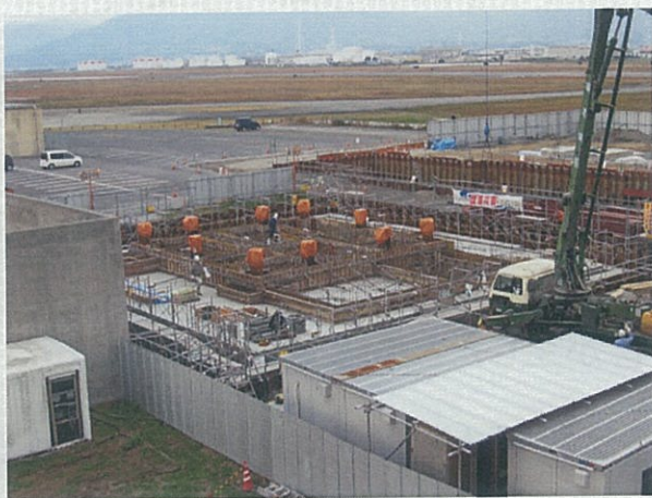
施設の建設工事の様子（イメージ）
