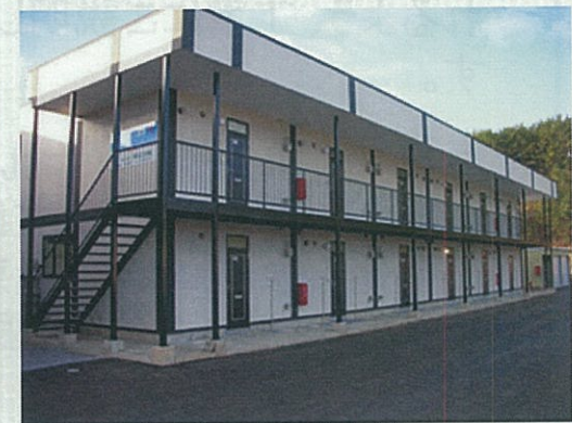
車力通信所に隣接する借上住宅
